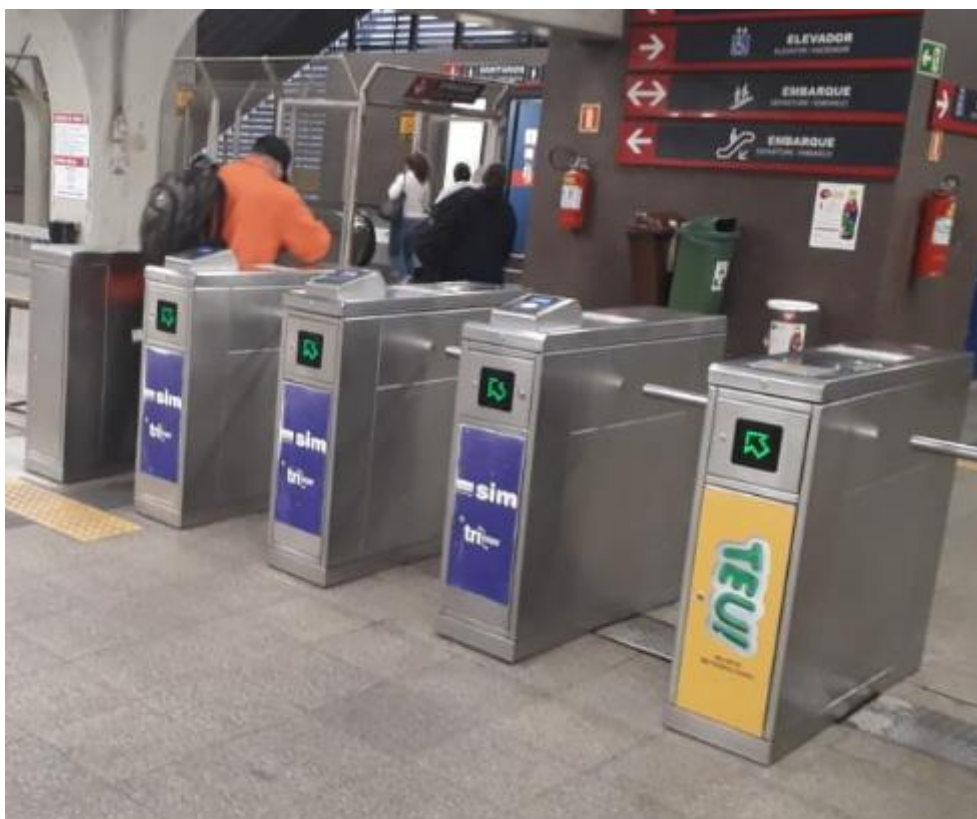
Figura 2 – Linha de bloqueios na Estação Canoas
