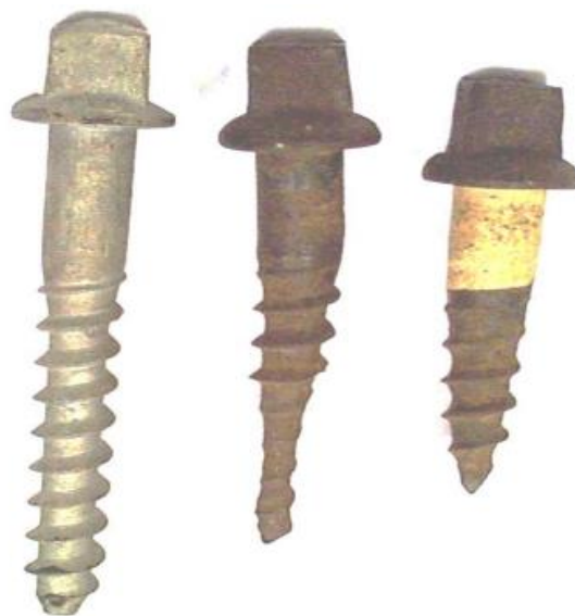
Figura 3 – Efeitos de corrosão em parafusos de fixação causados por corrente de fuga
