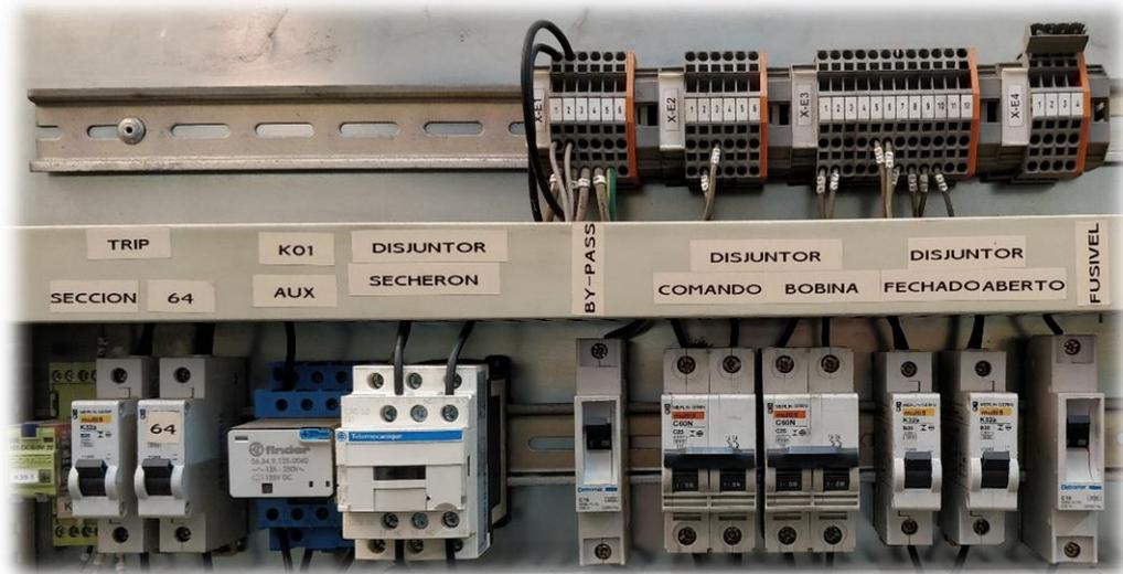
Figura 11 Mini Disjuntores para Simulações de entradas digitais
