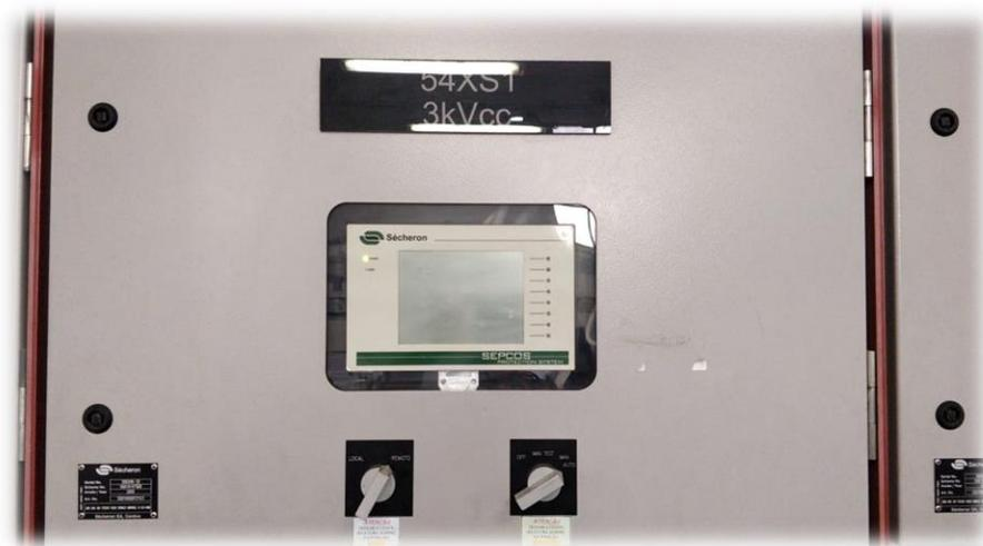
Figura 8 Painel Frontal Cubículo Alimentador
