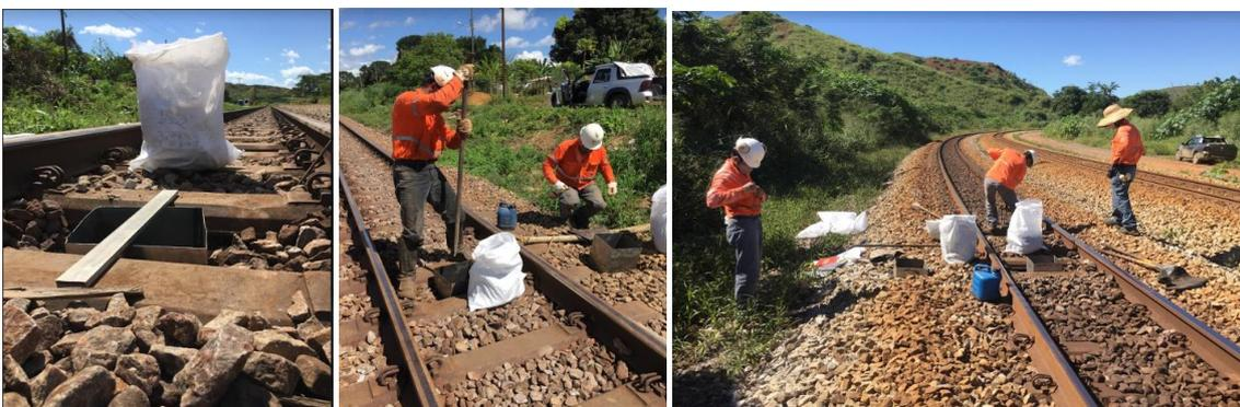
**Figura 10 – Coleta de lastro realizada no método tradicional para obter o índice de contaminação do lastro**
