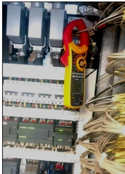
Figura 11 - Wattímetro instalado na alimentação de uma unidade de ar-condicionado. As estimativas do consumo de energia encontram-se no anexo “memórias de cálculo”.
